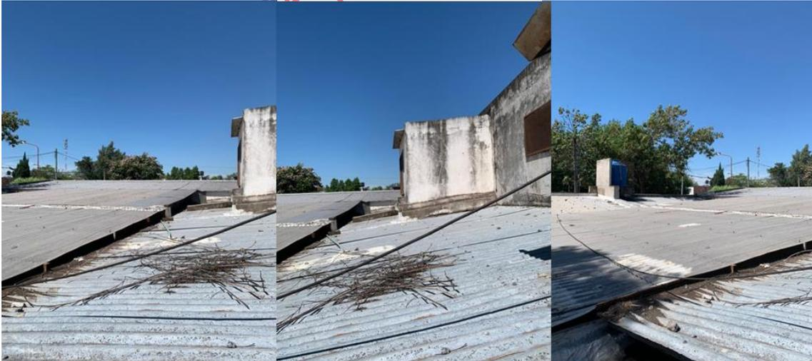
IMAGEN DE LA CUBIERTA DE CHAPAS A RETIRAR
