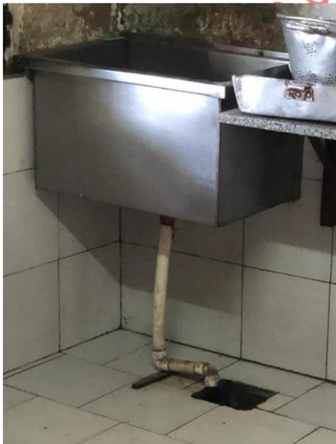
FOTO DEL DESAGÜE DE LA PILETA DE COCINA A RETIRAR, PARA REHACER EMBUTIDO.
